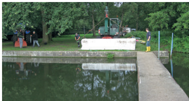
Abb. 3: Ausbringung der Sandmatten im Großen De Wittsee (Foto: Netteverband).
