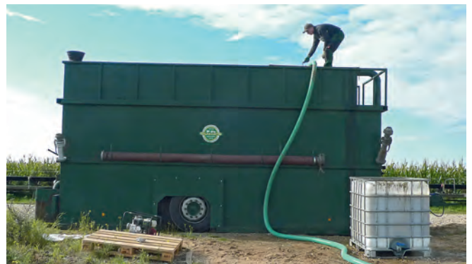
Abb. 5: Abpumpen und Zwischenlagerung des Wasser-Sediment-Gemisches am Diersfordter Waldsee (Foto: K. van de Weyer)
