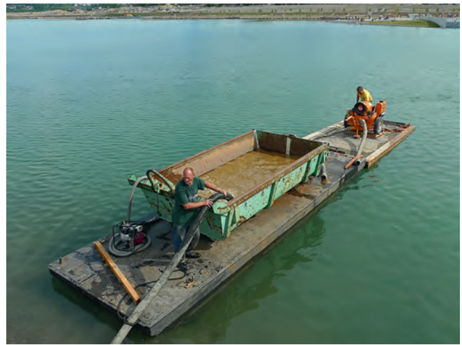
Abb. 7: Ausbringung des Wasser-Sediment-Gemisches im PHOENIX See im Mai 2011 (Foto: K. van de Weyer)
